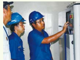
塗料供給ポンプを インバーターにより回転数をダウン
